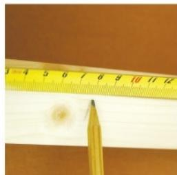
1. Распакуйте изделие. Расположите пластиковое крепление с прилагаемой подкладкой на верхней кромке рамы на расстоянии 80 мм от бокового края. Разметьте карандашом места крепления.
