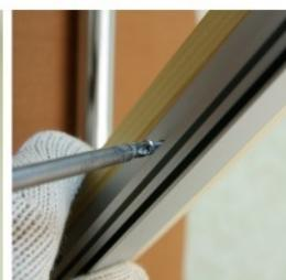
7. Выровняйте угол направляющей и закрепите шурпом. Внимание: не помещайте шнур натяжения между направляющей и рамой!!!
